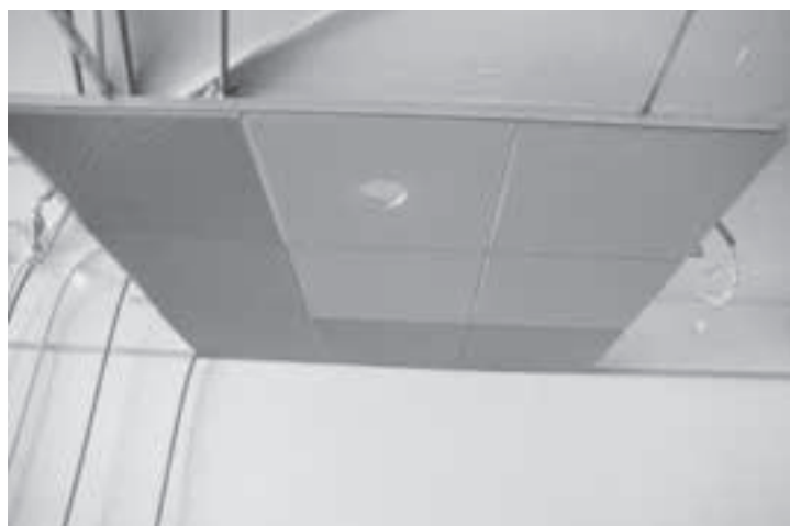
Die heruntergehängte Decke, zwischen der die ganzen Kabel verlegt werden.
