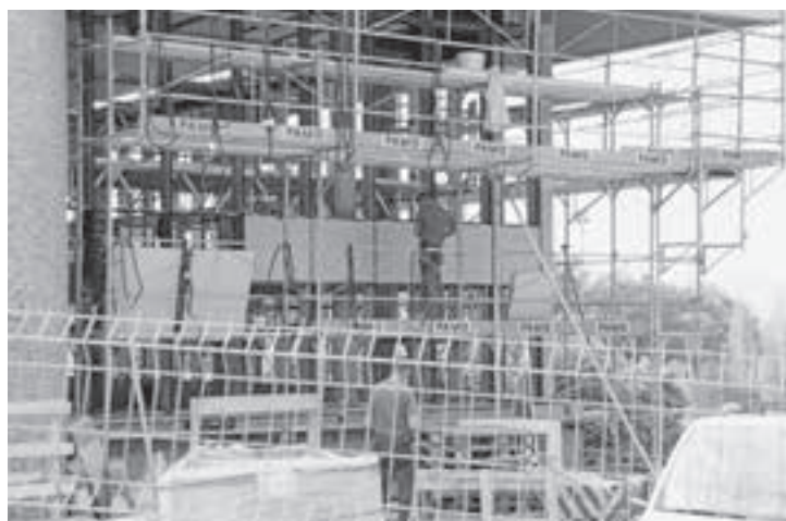
Die Fensterfront an der Stirnseite mit der Aussparung für den neuen Notausgang.
