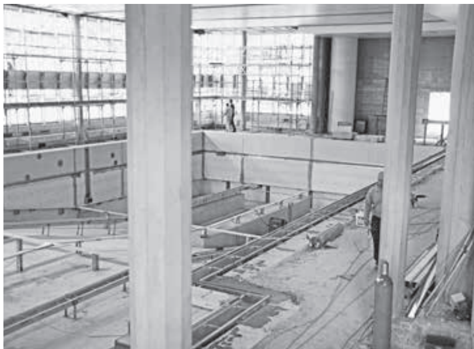
Blick in die Unterwelt: Der Raum für das neue Chromstahlbecken mit absenkbarem Boden.
