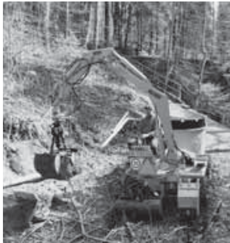
So entsteht ein Grillplatz.
