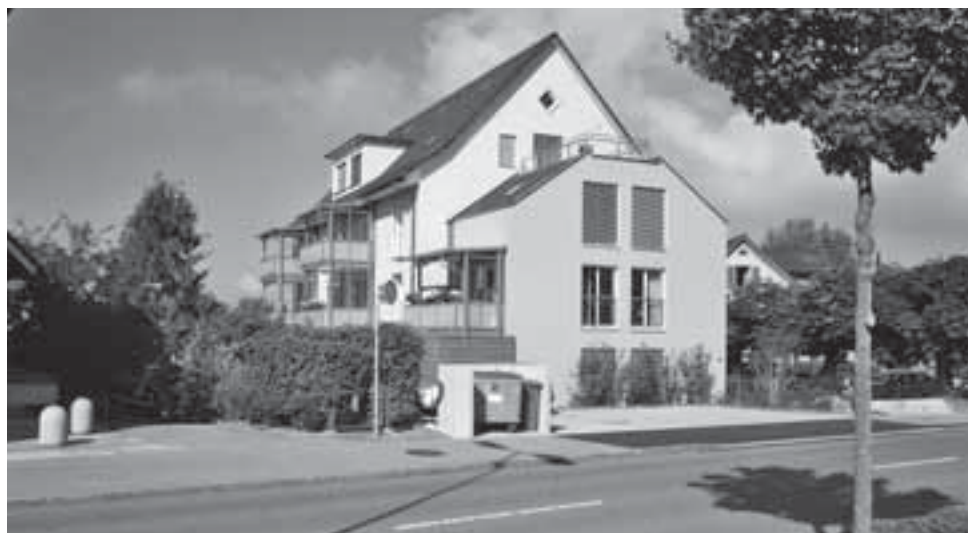
Das neue Förderprogramm von Zumikon unterstützt MINERGIE-Sanierungen wie hier an der Dorfstrasse 62.
