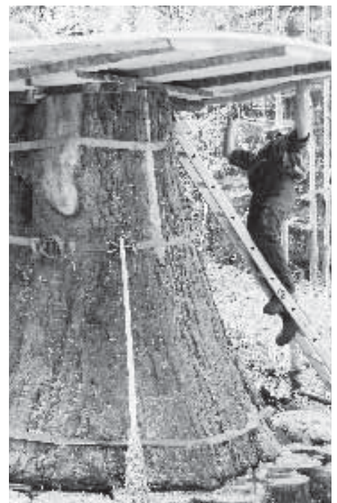
Das Dach wird montiert.
