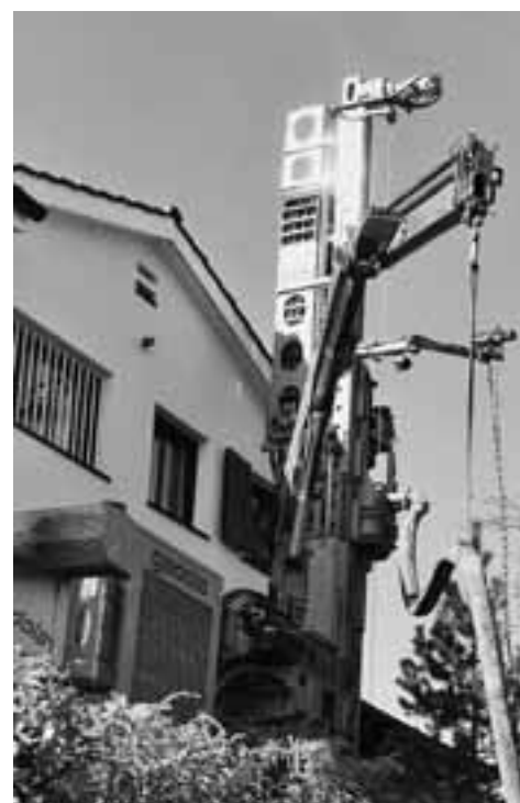
Erdsondenbohrung für ein Einfamilienhaus
