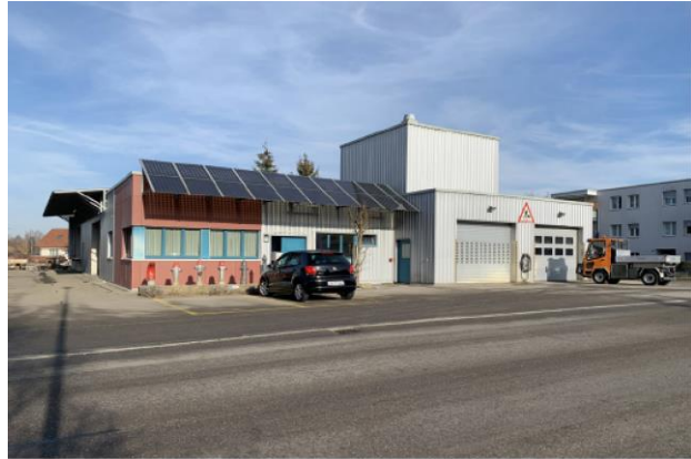
Vordach mit Sonnenkollektoren, Schwäntenmos 9
