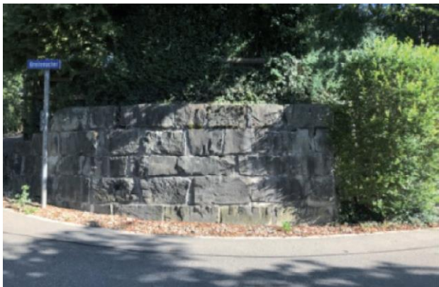
Natursteinstützmauer im Streiflicht
