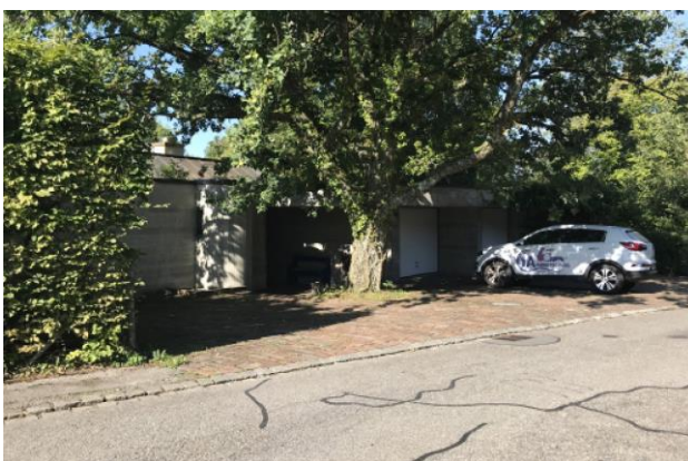
Gliederung Garageneinfahrt durch markanten Baum, Wengi 6
