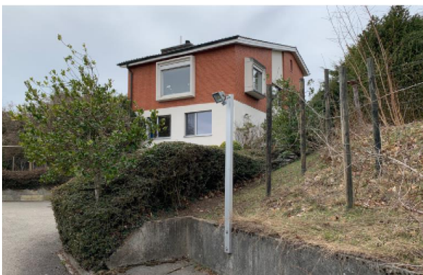
Mischbau mit Aussichtsfenster, Ebnetweg 4
