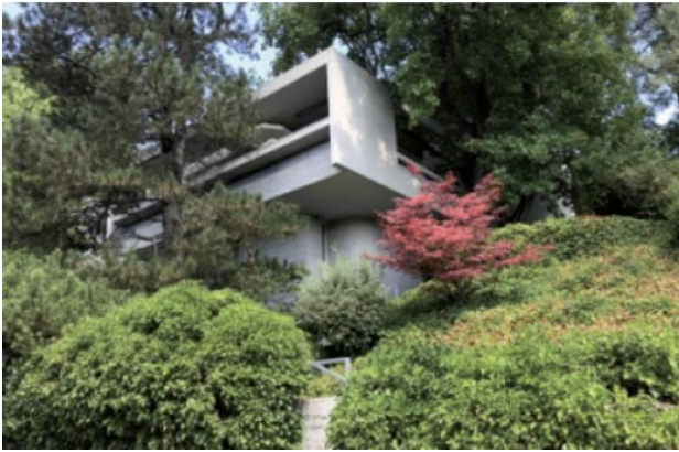
Klassischer Sichtbeton, Tobelweg 6
