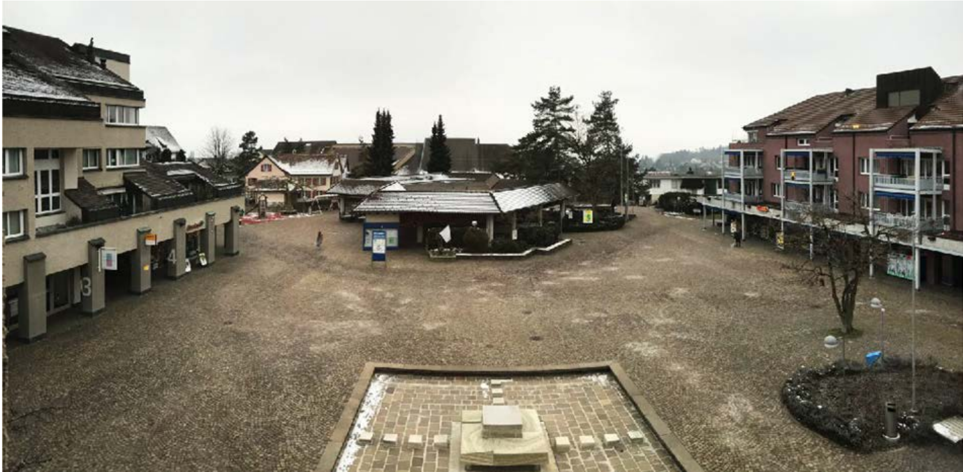
Gezacktes Vordach über Abgängen in Tiefgarage und Forchbahn bildet keinen Platzabschluss
