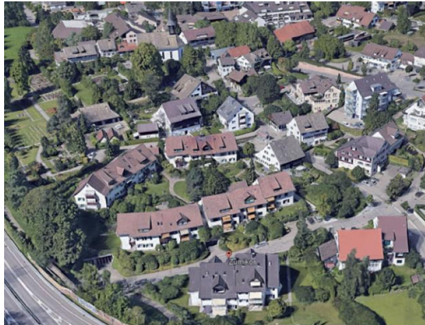
Grundstrasse, Unterdorfstrasse, Kirche, Kernzone
