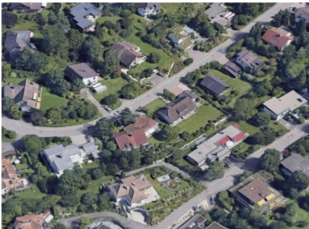
Dachaufsichten Ringstrasse Lettenstrasse
