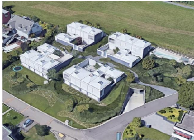
Bewegung im Dach Rigistrasse / Haldenstr. 1
