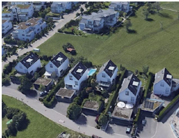
Begrünung der Garagendächer, Huebstrasse
