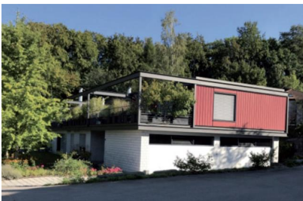
Mischbau: Begrünte Dachterrasse, Lettenstr. 16
