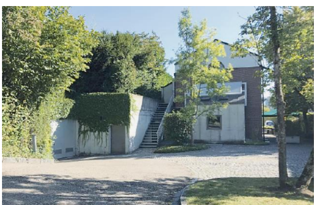
Kletterpflanzen an Stützmauer, Küsnachterstr. 38
