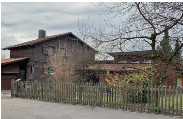
Holzbau mit Erweiterungen, Ebnet 17
