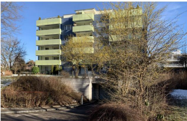
Sanierungsobjekt, In der Gand 1
