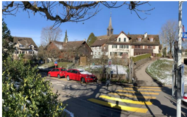
Kernzone Zentrum, Unterdorfstrasse 11
