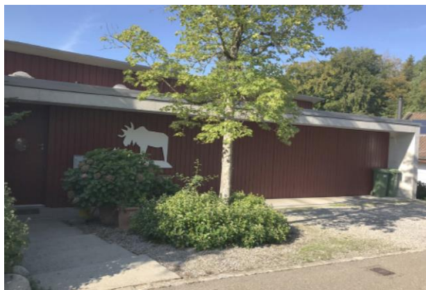
Belagsänderung ohne Bodenversiegelung, Rebusstr. 56
